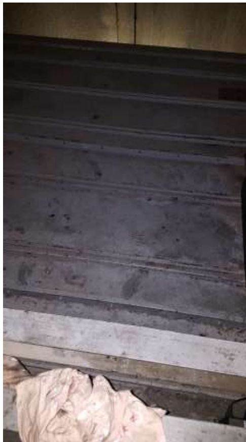
Toit de cabine.
